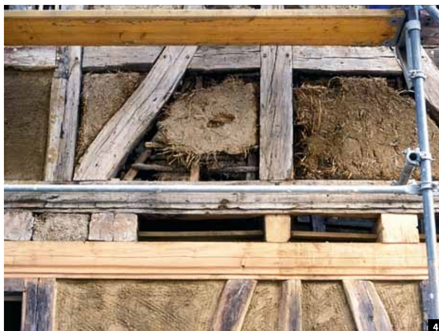
Abb. 4: Reparatur von Strohlehmgefüchen: Intakte Teile werden erhalten und die Fehlstellen mit wieder aufbereitetem Material ergänzt.
