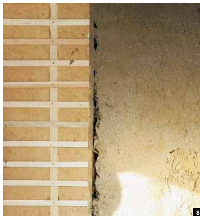
Abb. 8: Das Außenwandmauerwerk wird mit einer Holzfaserdämmung von innen gedämmt. Als Bekleidung wird ein Leichtlehmunterputz auf Lattung ausgeführt (vgl. Abb. 7).
